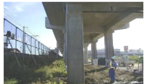
施工例:橋脚中性化防止工
